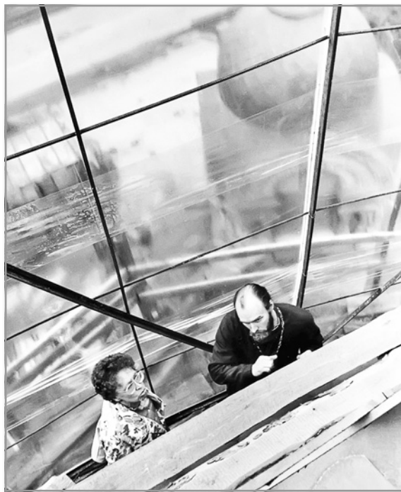
Купол собора. Протоиерей Александр Новопашин осматривает купол собора перед установкой на него покрытия из золота. 1991 год
