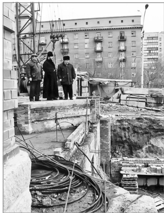
Строительство Крестильного храма во имя Иоанна Предтечи
