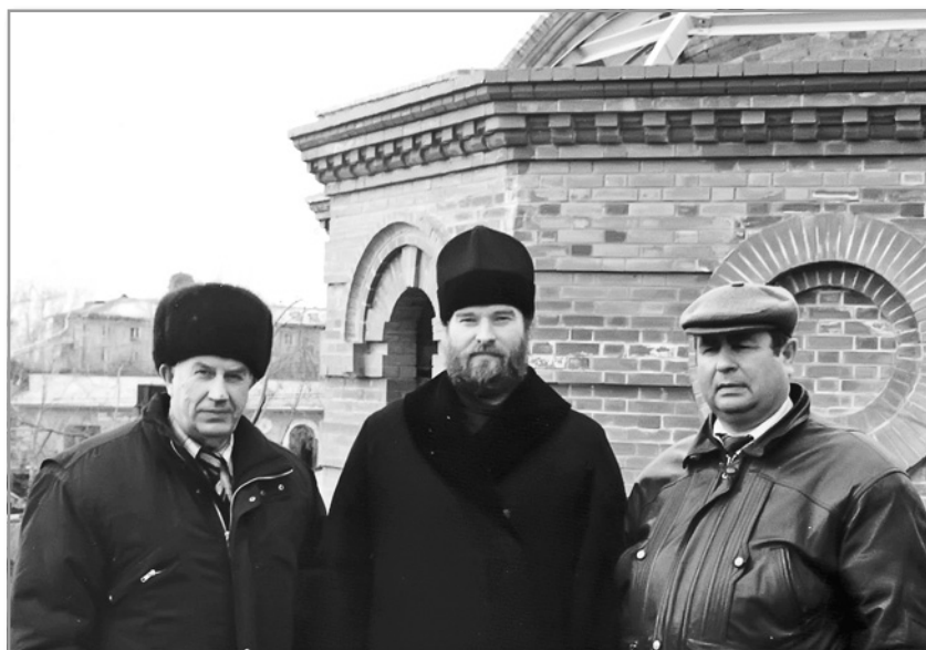
Настоятель собора во имя святого благоверного князя Александра Невского с прорабом И.В. Пестуновым и помощником по строительству А.Н. Ягофаровым на строительстве Крестильного храма
